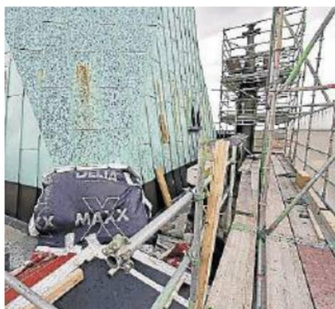
**Die Brüstung aus Sandstein ist teils schon gelöst und zerlegt. Alle Steinelemente werden ab Mittwoch vom Kirchturm abmontiert und herabgelassen.** FOTO HENNES
