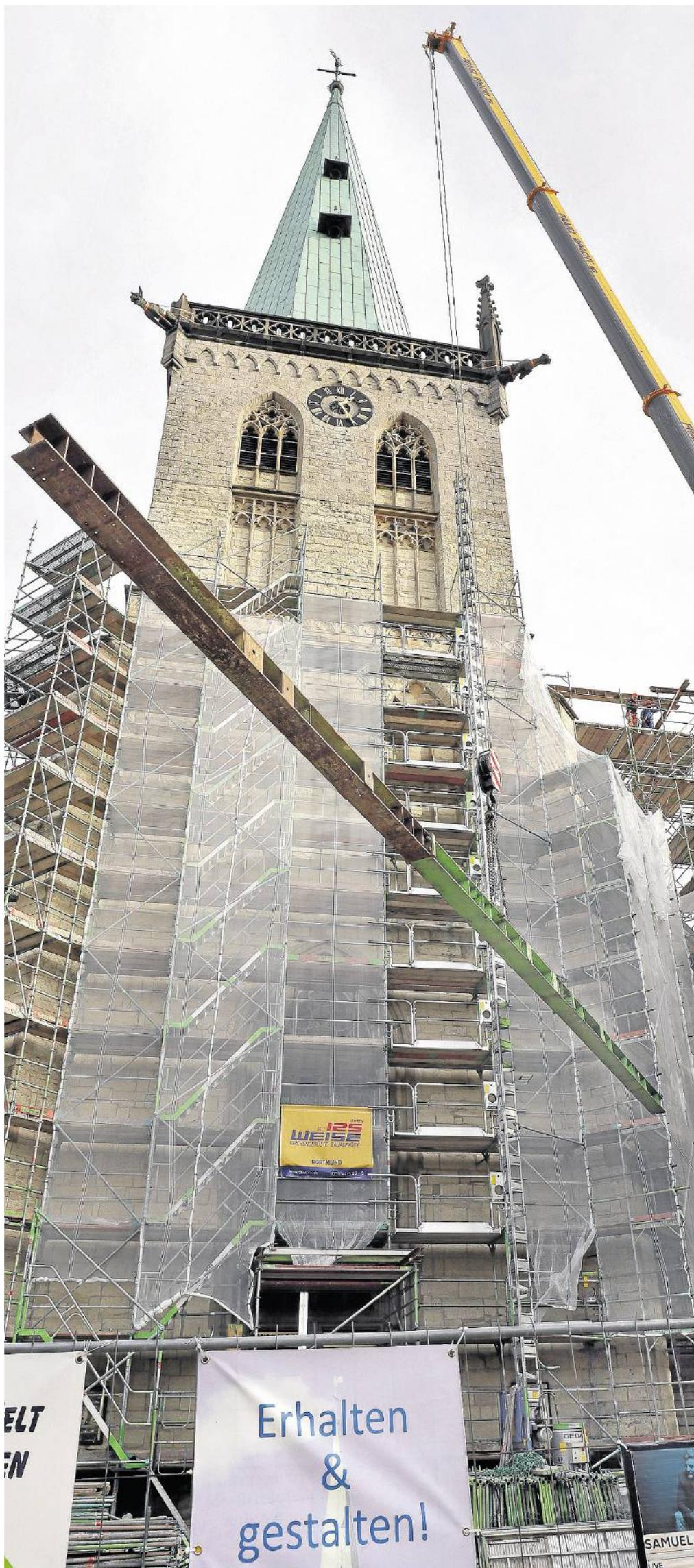
Mit großen Eisenträgern wurde eine Art „Zwischenboden“ des Gerüsts gebaut. Für den Transport nach oben war ein Spezialkran notwendig.
